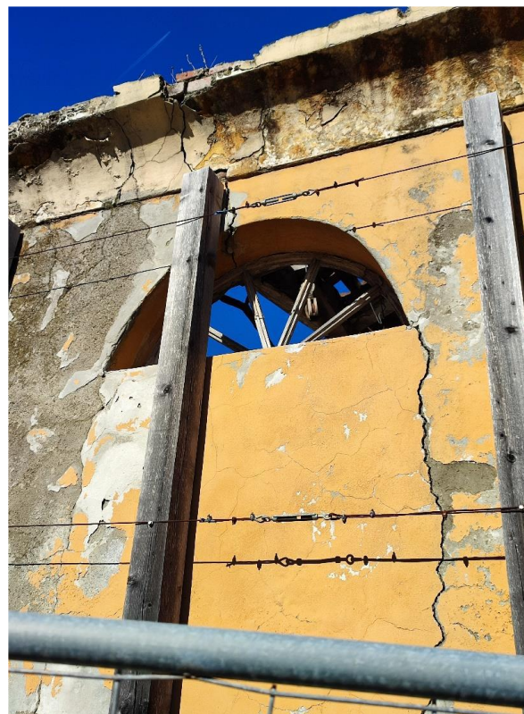
Figura 79. Fabbricato 118 - Fessurazione architravi
