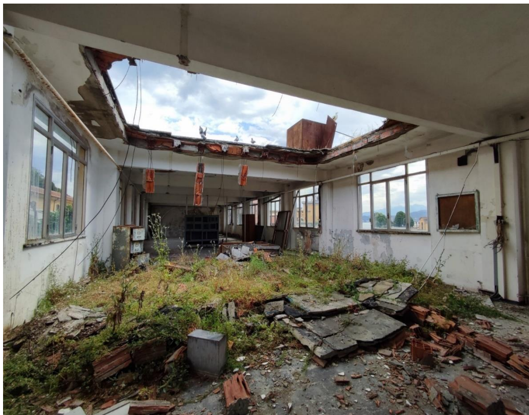
Figura 122. Fabbricato 153 - Primo piano - Porzione di copertura crollata, gravante su solaio inferiore
