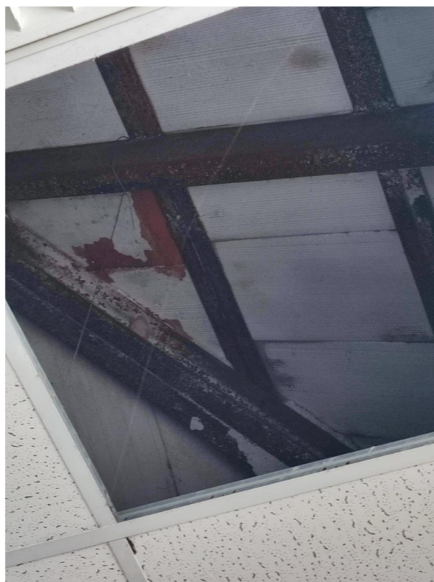
Figura 97. Dettaglio travi metalliche di copertura del Fabbricato 143
