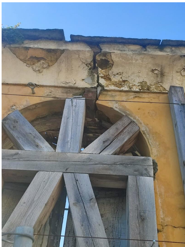
Figura 79. Fabbricato 118 - Fessurazione architravi
