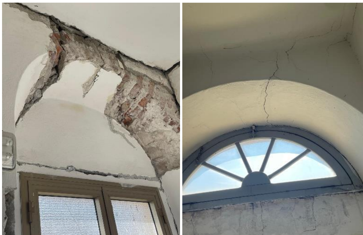
Figura 85. Fabbricato 118A - Fessurazioni fasce sopra-finestra
